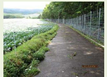
(農地周辺に整備された防護柵)
