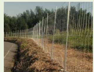
(侵入防止柵の設置)
