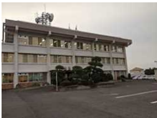
藤岡合同庁舎 本館
