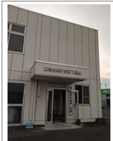
藤岡合同庁舎 別館
