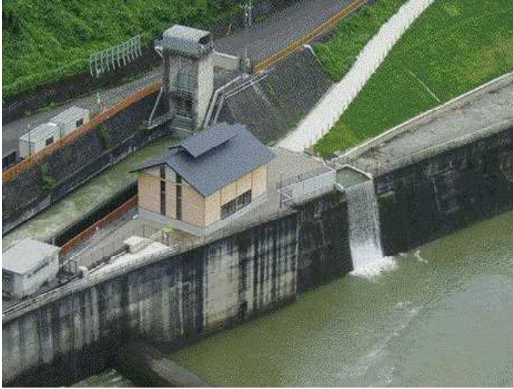
東第二発電所外観
