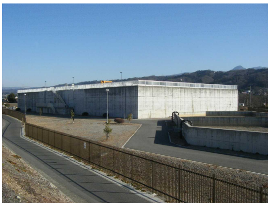
渋川工業用水道原水調整池
