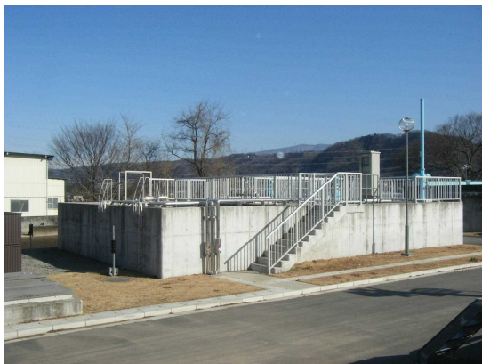
渋川工業用水道混和池
