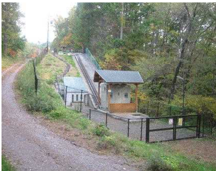
狩宿第二発電所外観
