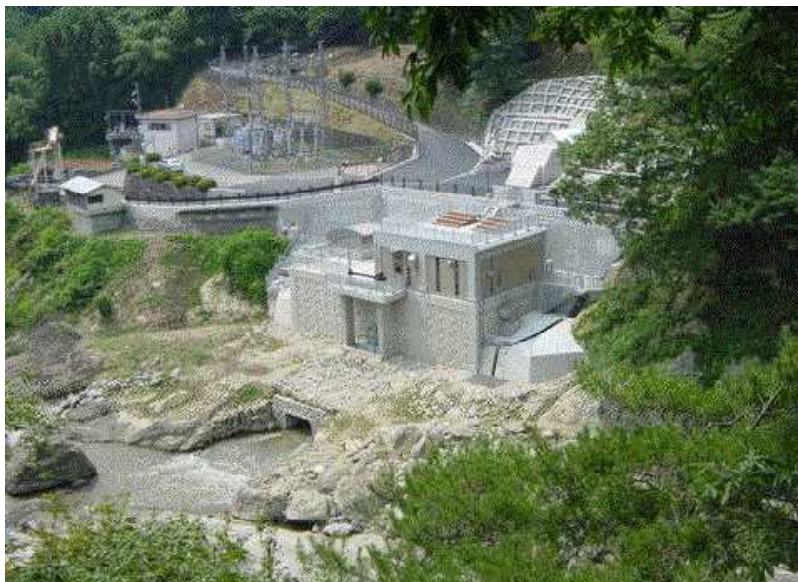
新利南発電所外観
