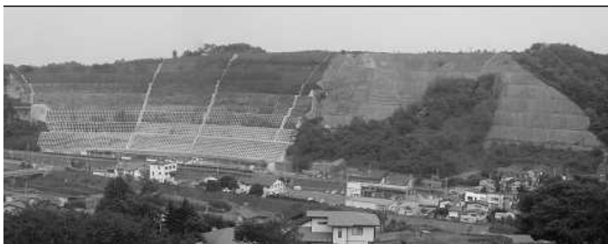
急傾斜地崩壊対策事業 孺恋村笹平地区
