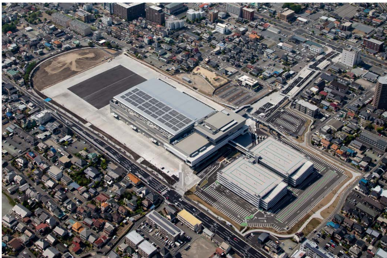
群馬コンベンションセンター太陽光発電所
