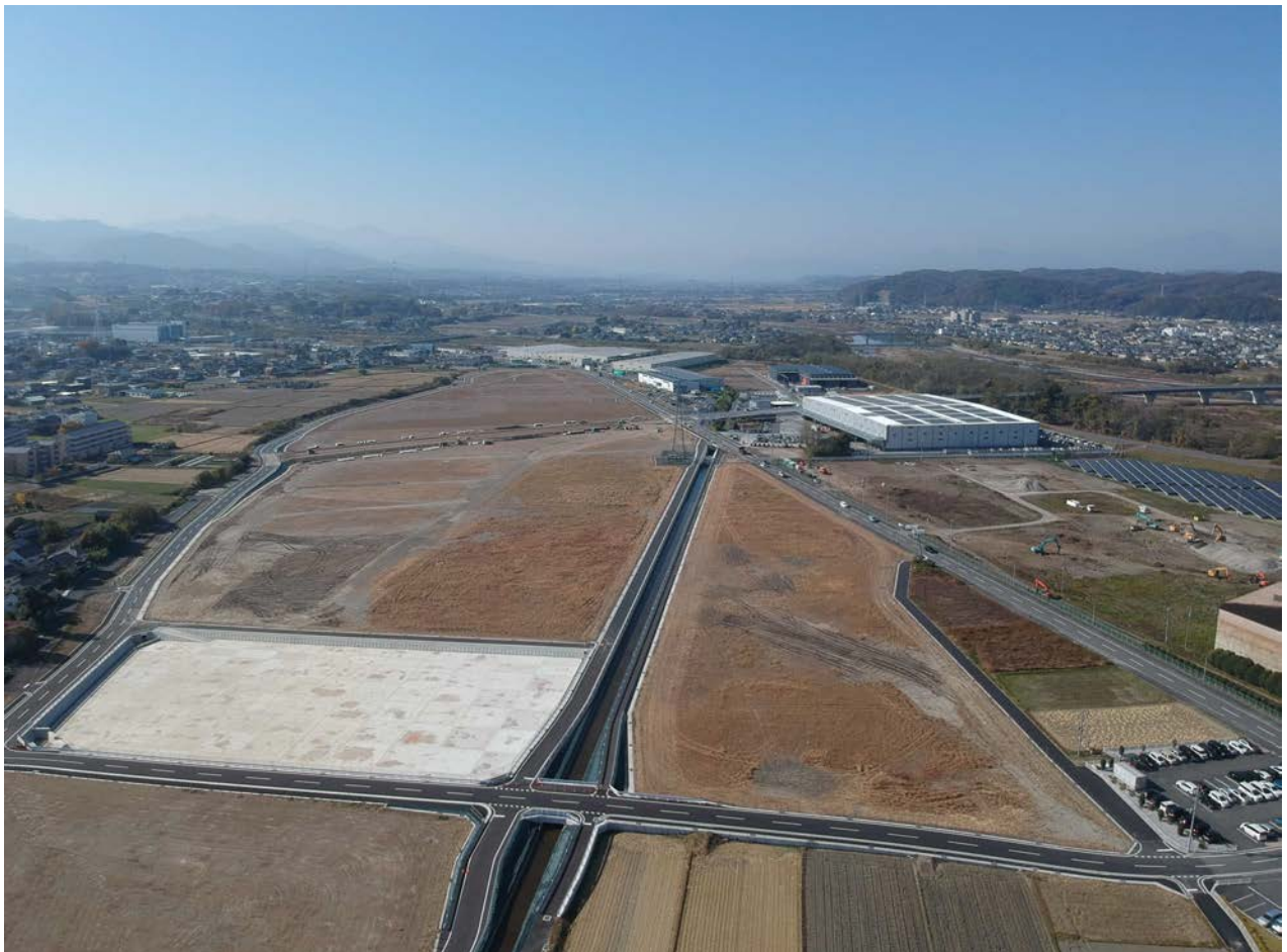
藤岡インターチェンジ西産業団地
