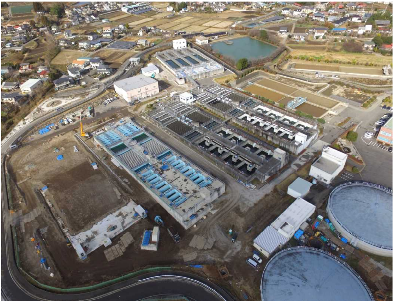
県央第一水道事務所 3号浄水池建設工事
