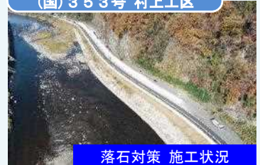
落石対策 施工状況
