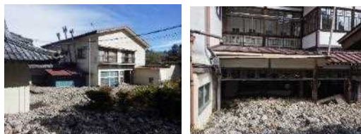
着手前（被災した新鹿沢温泉）
