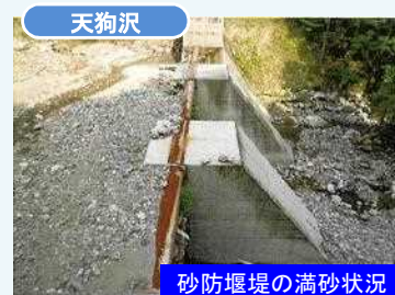
砂防堰堤の満砂状況
