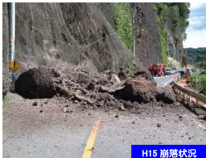
H15 崩落状況
