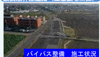
渡良瀬幹線道路（笠懸藪塚工区）
