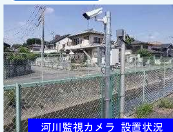
河川監視カメラ 設置状況
