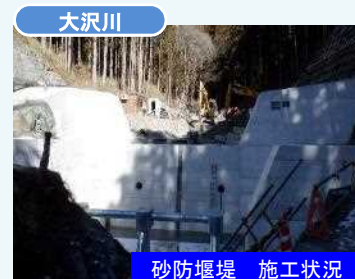
砂防堰堤 施工状況
