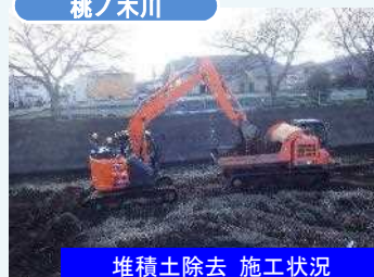
堆積土除去 施工状況
