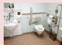
高齢者・障害者対応トイレ
