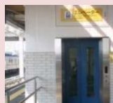
エレベーター設置
