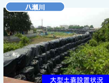
大型土嚢設置状況
