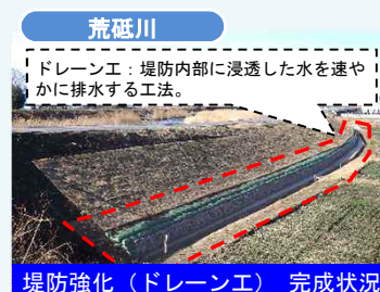
堤防強化(ドレーン工) 完成状況
