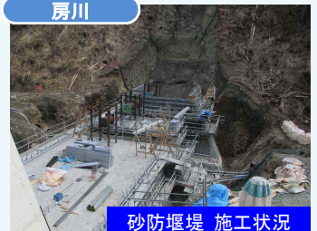
砂防堰堤 施工状況
