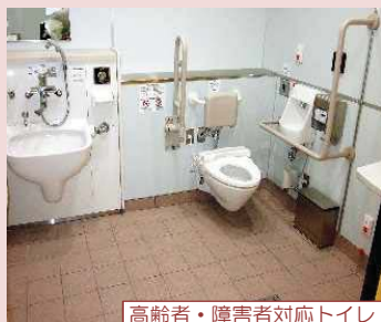
高齢者・障害者対応トイレ
