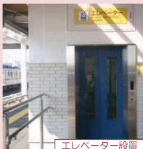
エレベーター設置
