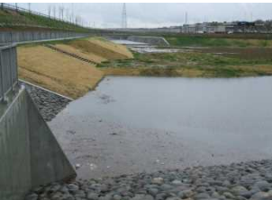
大原西調節池 【A池】(H19整備完)
