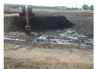
北金井菅塩調節池 【E池】(施工中)
