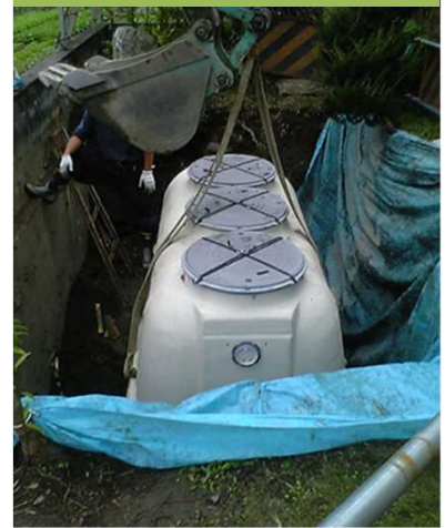
藤岡市浄化槽 施工状況
