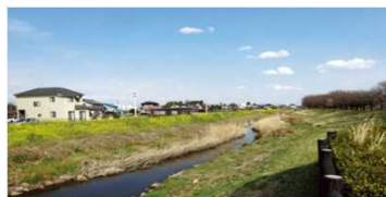
緩傾斜護岸（石田川 太田市）
