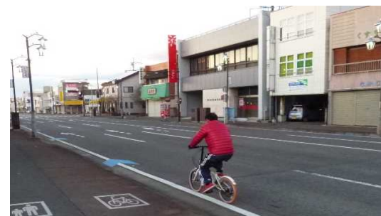
(主) 高崎渋川線 矢羽型路面標示整備状況
