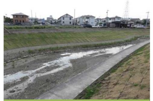
男井戸川（伊勢崎市） 施工状況
