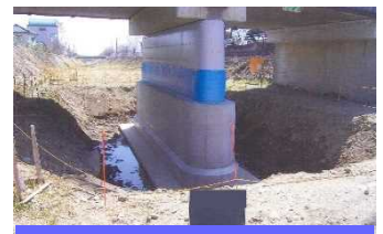
県道前橋大間々桐生線 粕川橋施工状況
