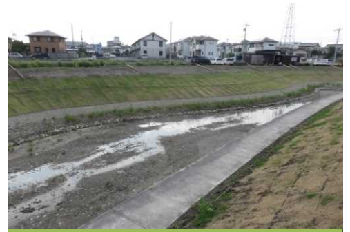
男井戸川（伊勢崎市） 施工状況
