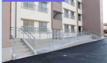
屋外スロープ
