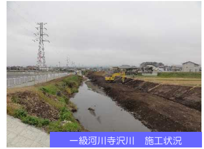
一級河川寺沢川 施工状況
