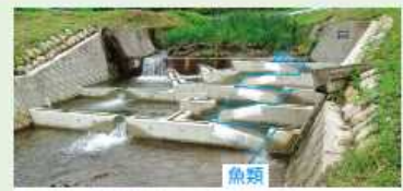
魚道（押野川 みなかみ町）
