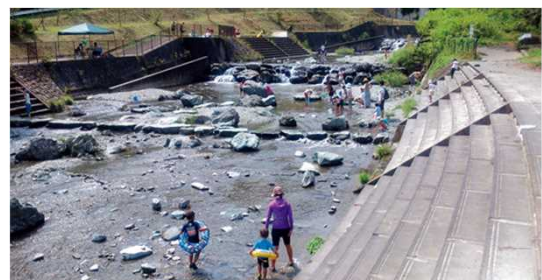
階段工（三波川 藤岡市）
