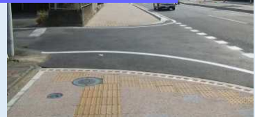
歩道の段差解消・視覚障害者誘導用ブロック設置
