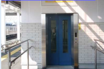
段差解消（エレベーター設置）
