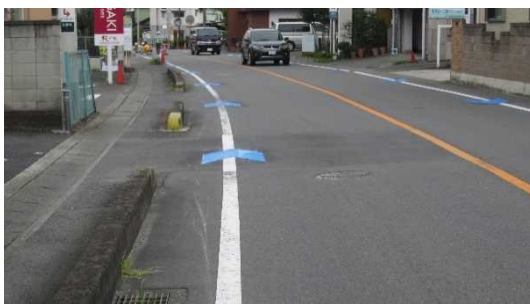
(主) 高崎神流秩父線 矢羽型路面標示整備状況
