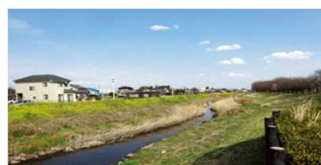
緩傾斜護岸（石田川 太田市）
