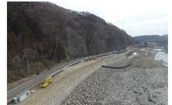
国道353号 村上工区 施工状況
