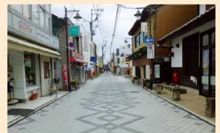
おもてなし舗装*の整備 (富岡市)
