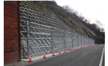
国道120号 菅沼工区 施工状況
