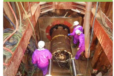
伊勢崎幹線管渠 施工状況
