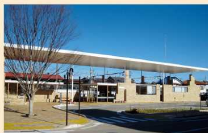
上州富岡駅周辺整備 (富岡市)
