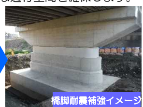
橋脚耐震補強イメージ
