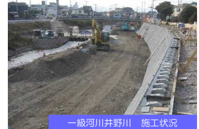
一級河川井野川 施工状況
