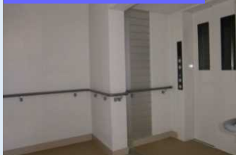
エレベーター、廊下の手すり
