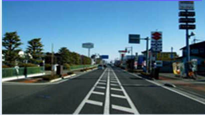
無電柱化の例 (国道254号：富岡市)
