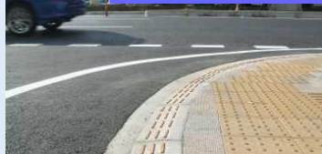
歩道の段差解消・視覚障害者誘導用ブロック設置
