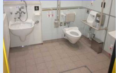
高齢者・障害者等対応トイレ
