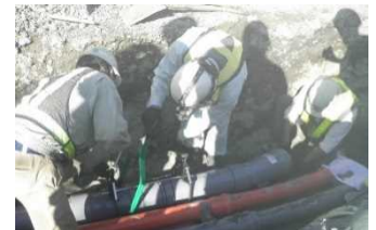
県道藤岡本庄線 藤岡工区 施工状況
