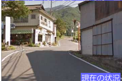
県道上発知材木町線 透門橋工区
