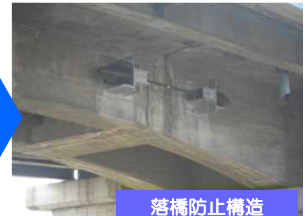
落橋防止構造
