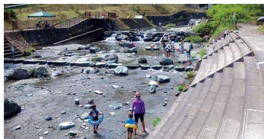
階段工（三波川 藤岡市）
