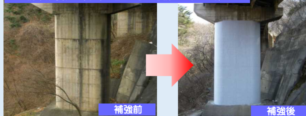
橋梁耐震化の例 (国道254号11号橋：下仁田町)
