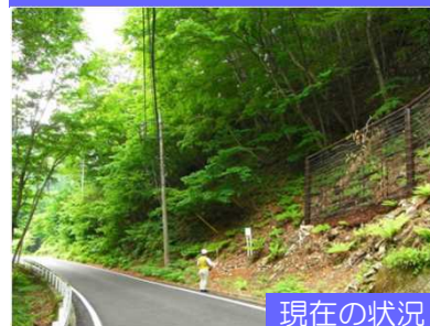
県道法師吹路線 永井工区
