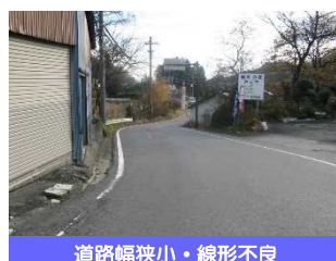
道路幅狭小・線形不良
