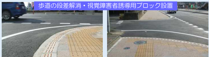
歩道の段差解消・視覚障害者誘導用ブロック設置
