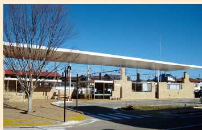
上州富岡駅周辺整備 (富岡市)
