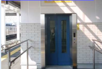
段差解消（エレベーター設置）
