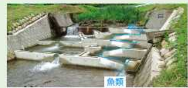
魚道 (押野川 みなかみ町)
