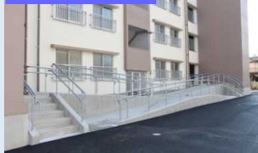
屋外スロープ
