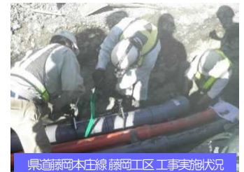
県道藤岡本庄線 藤岡工区 工事実施状況
