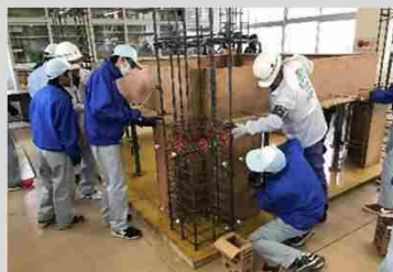
学校実習(鉄筋・型枠実習)
