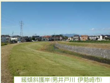
緩傾斜護岸(男井戸川 伊勢崎市)
