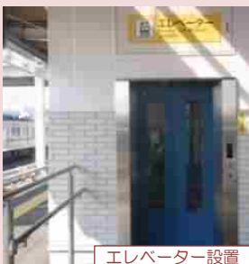
エレベーター設置
