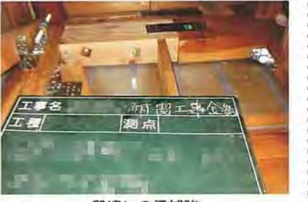
段違いの梁補強
