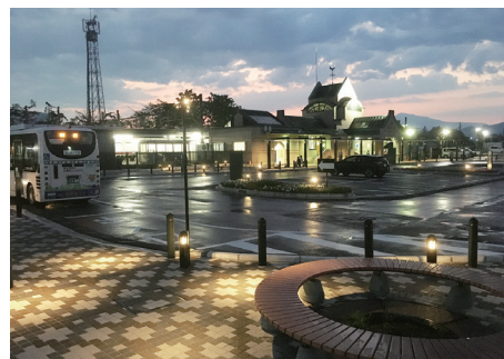
夜間照明の様子
