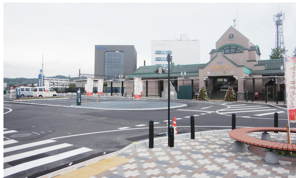
完成した駅前広場
