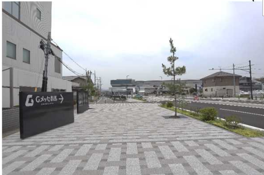
・交差点部は広々とした歩道空間として整備、案内看板やシンボルツリーを設置。 ・歩道舗装ブロックに天然骨材洗出しブロック(劣化しにくい材料)を使用。 ・群馬の絹糸産業をイメージした織物の模様を舗装ブロックでデザイン。
