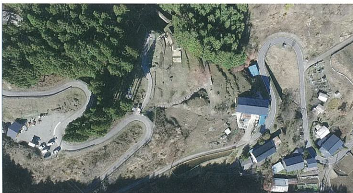
荒船風穴の周辺状況
