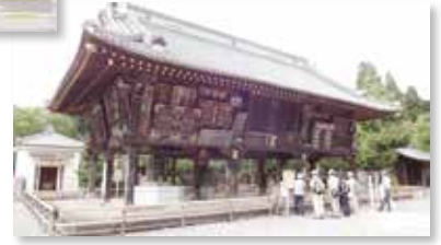
園十郎が寄進したとされる額堂 (1861(文久元)年に建立された 重要文化財)。
