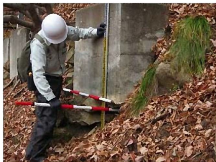
雪崩予防柵工基礎部
