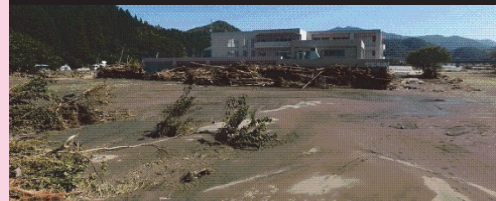
高齢者利用施設の被災（岩手県岩泉町）
