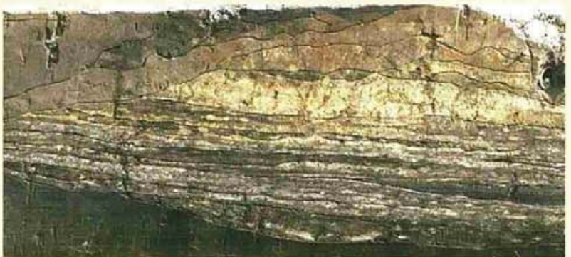
(写真3) “版築”の様子を示す道路の断面
