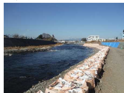
護岸工事状況
