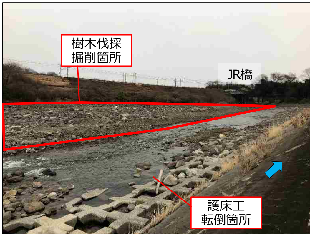
掘削前（R2年1月）
