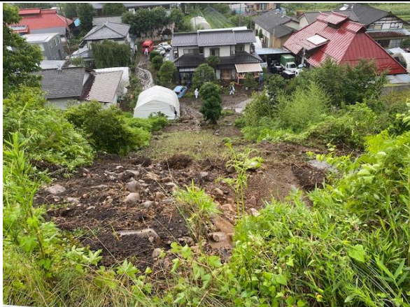
③令和3年7月 集中豪雨 土砂崩れ
