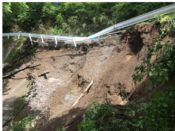
②令和元年6月 集中豪雨 山崩れ
