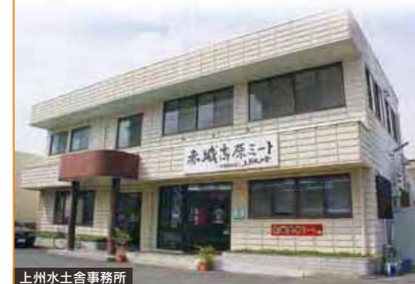
上州水土舎事務所
