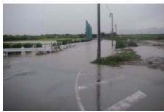
高崎市阿久津地先の浸水状況
