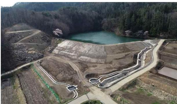
池田地区では、地震時に堤体が決壊する恐れがあることから、堤体の安定を図る補強工事に着手しました。
