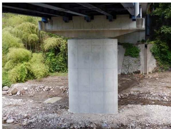
赤城南第2地区では、農道の橋梁において、耐震性を確保するための橋脚の補強工事を実施し、流通・県民生活を支える道路としての機能向上を図りました。
