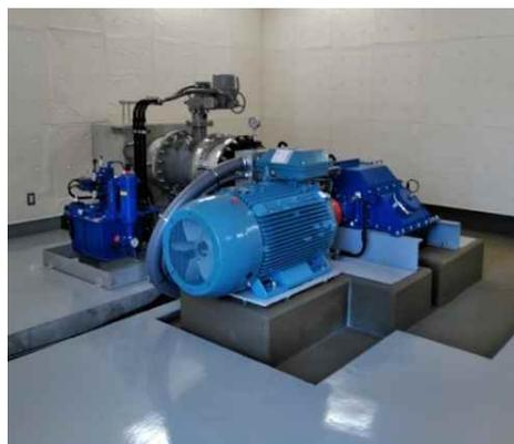
赤城大沼用水土地改良区では、地域の重要な農業水利施設である赤城大沼用水の落差エネルギーを有効活用し、79世帯分の電気料\*に相当する発電を行い、土地改良区の維持管理費等の軽減を図っています。 \*計画年間発電量 351,000kwh
