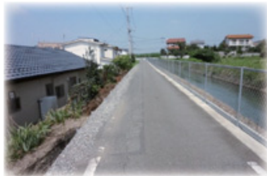
耐震性調査を行う農業水利施設 (前橋市：大正用水地区)
