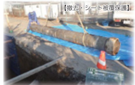
石綿セメント管を撤去し塩化ビニール管等に交換 (前橋市：横沢地区)
