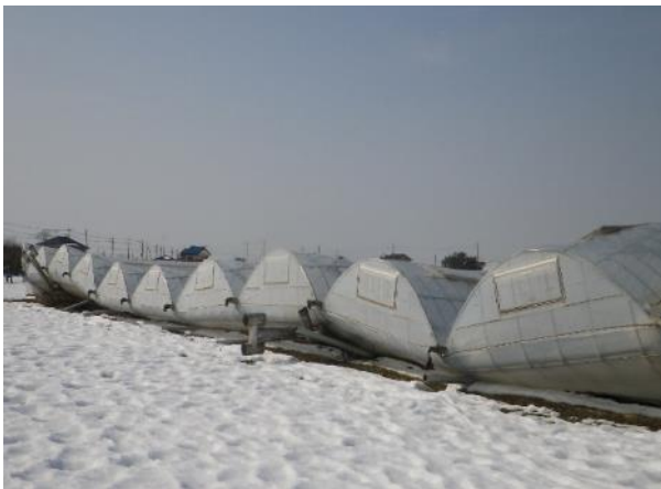
平成26年2月に発生した雪害 ハウス倒壊は県内で最も多かった
