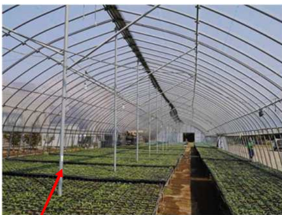
【 間口が9 mと広いが固定の中柱で補強 】
