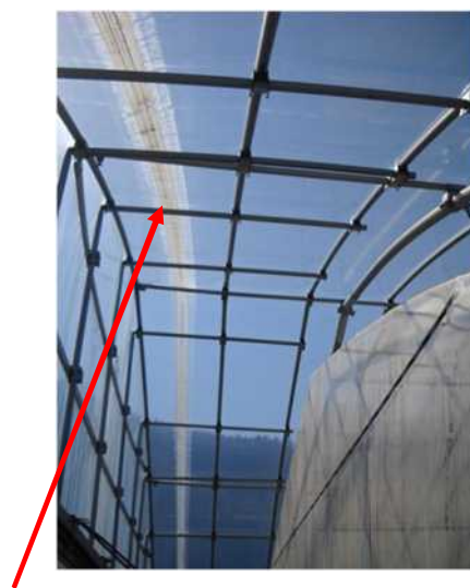
【 北側の妻面補強状態赤矢印は軒の部分 】
