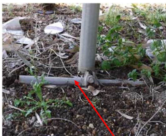
【 中柱の沈み込み防止のためパイプを利用 】
