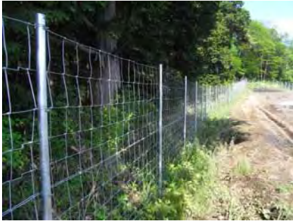
○侵入防止柵の設置
