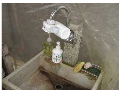
○ 手洗い場の設置
