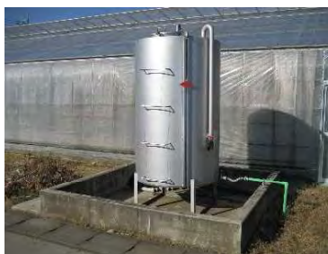
○ 防油堤の設置
