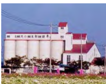
カントリーエレベーター
