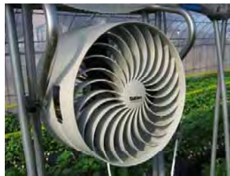
○ 循環扇の設置
