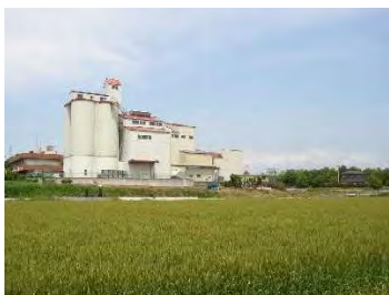
カントリーエレベーター
