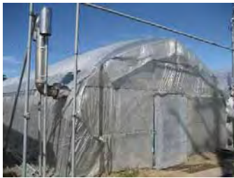
○ 空気膜ハウスの設置
