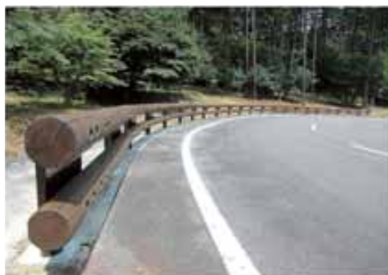
写真：木製ガードレール
