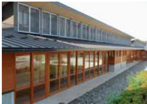
写真：県産材を使用した公共建築物(中学校)
