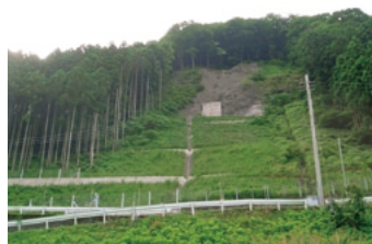
山腹崩壊復旧工事
