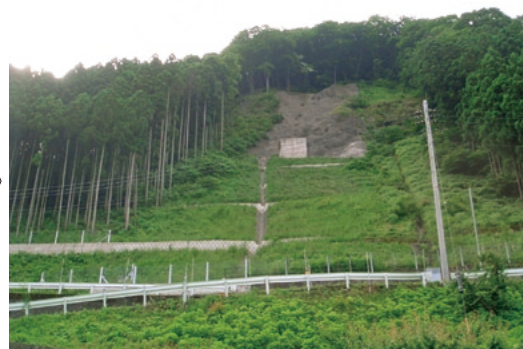
写真：山地災害の復旧
