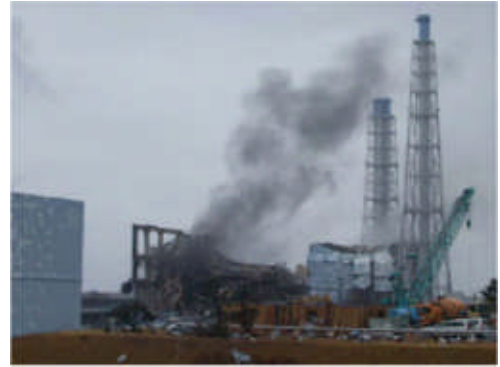
東京電力(株)福島第一原発3号機(平成23年3月21日撮影) (東京電力(株)提供)
