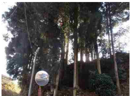
東吾妻4 困難地整備支援 古谷地区森林伐採事業
