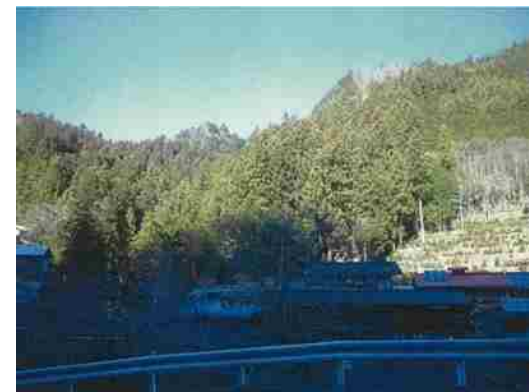
南牧8 管理 六車赤岩地区 林地荒廃対策整備
