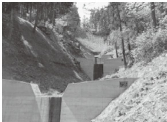
山地逕流を保全する治山ダム工
