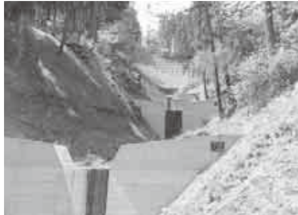
山地逕流を保全する治山ダム工
