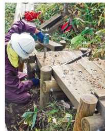
木道工事のようす
