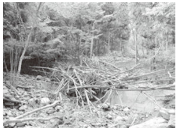
流木及び土砂の流出を抑制した治山ダム工
