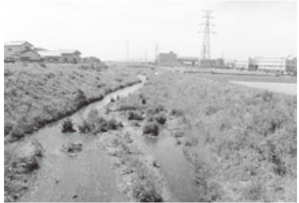
一級河川寺沢川 前橋市
