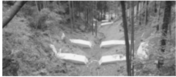
山地溪流を保全する治山ダム工
