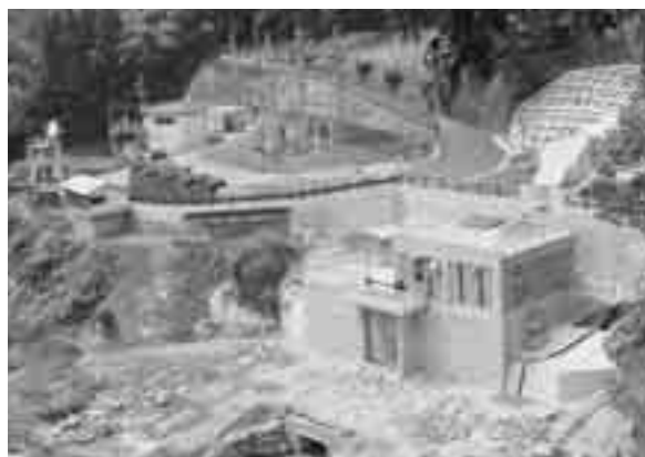
新利南発電所建屋全景
