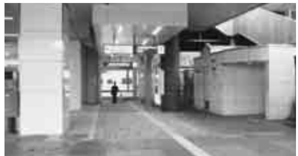
上信電鉄高崎駅連絡通路の整備
