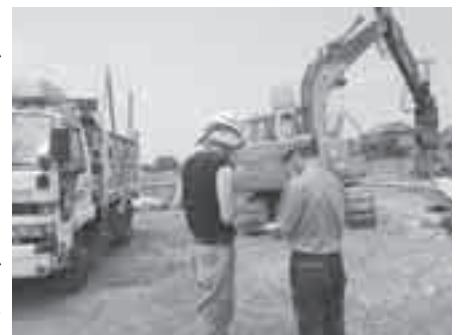
解体工事現場監視指導
