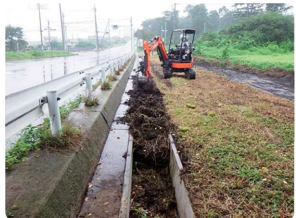
村道維持補修工事2(昭和村)
