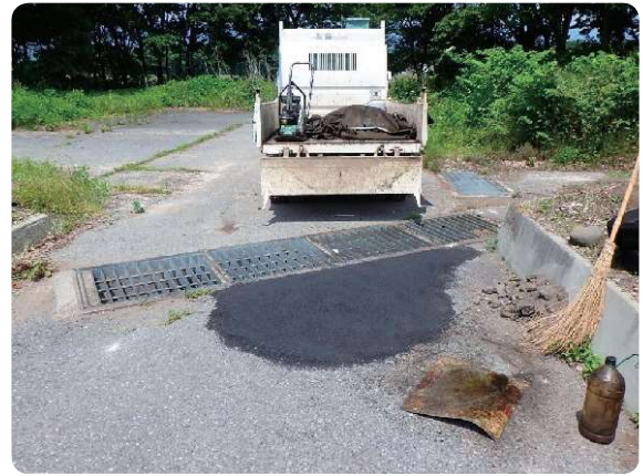
村道維持補修工事1(昭和村)
