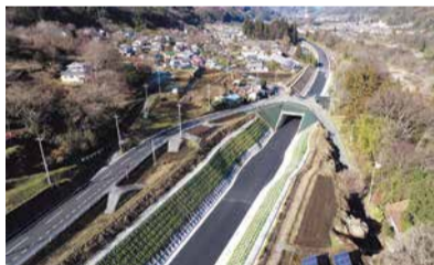
バイパス整備状況(上信自動車道)
