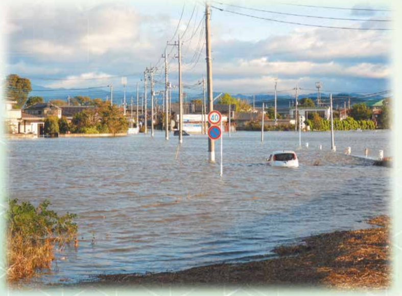
令和元年東日本台風による被害の様子(太田市)
